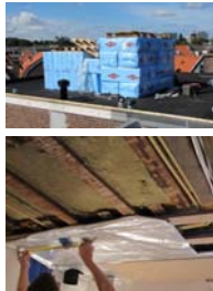
140 mm steenwol tussen de balken, 80 mm geextrudeerd PS op de dakbedekking
